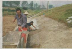
进入汛期后,该镇针对各项水利设施建设和河道进行了检查和除险。目前已投入近100万资金,先后完成东庄水库坝顶东西两端防渗处理、小汤坝水库高涵坝门补缺、墩墩山水库溢洪道西侧渗漏处理、仓山水库南干渠溢洪道侧渗漏处理等工程,从而确保了防汛工作的万无一失。 陈峰 文飞 摄影报道
